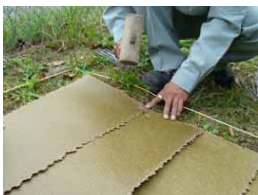
防草シートはピンで固定し太陽光が入らないように重ねて敷設する
